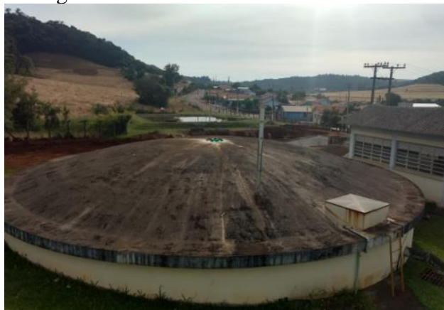
Figura 21: Reservação e Lagoas de tratamento de lodo ao fundo.
