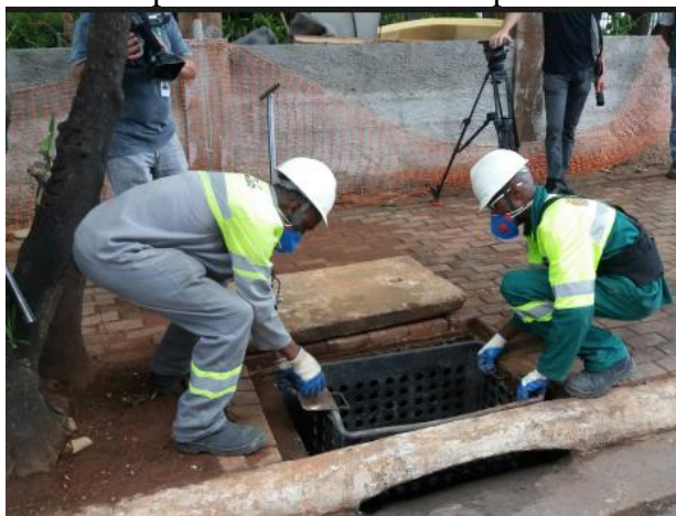
Figura 118: Modelo de cesta acopladas as bocas de lobo para coleta de resíduos.
