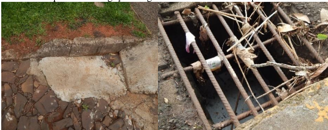
Figura 77: Casos que indicam ligação irregular de efluentes na rede pluvial.
