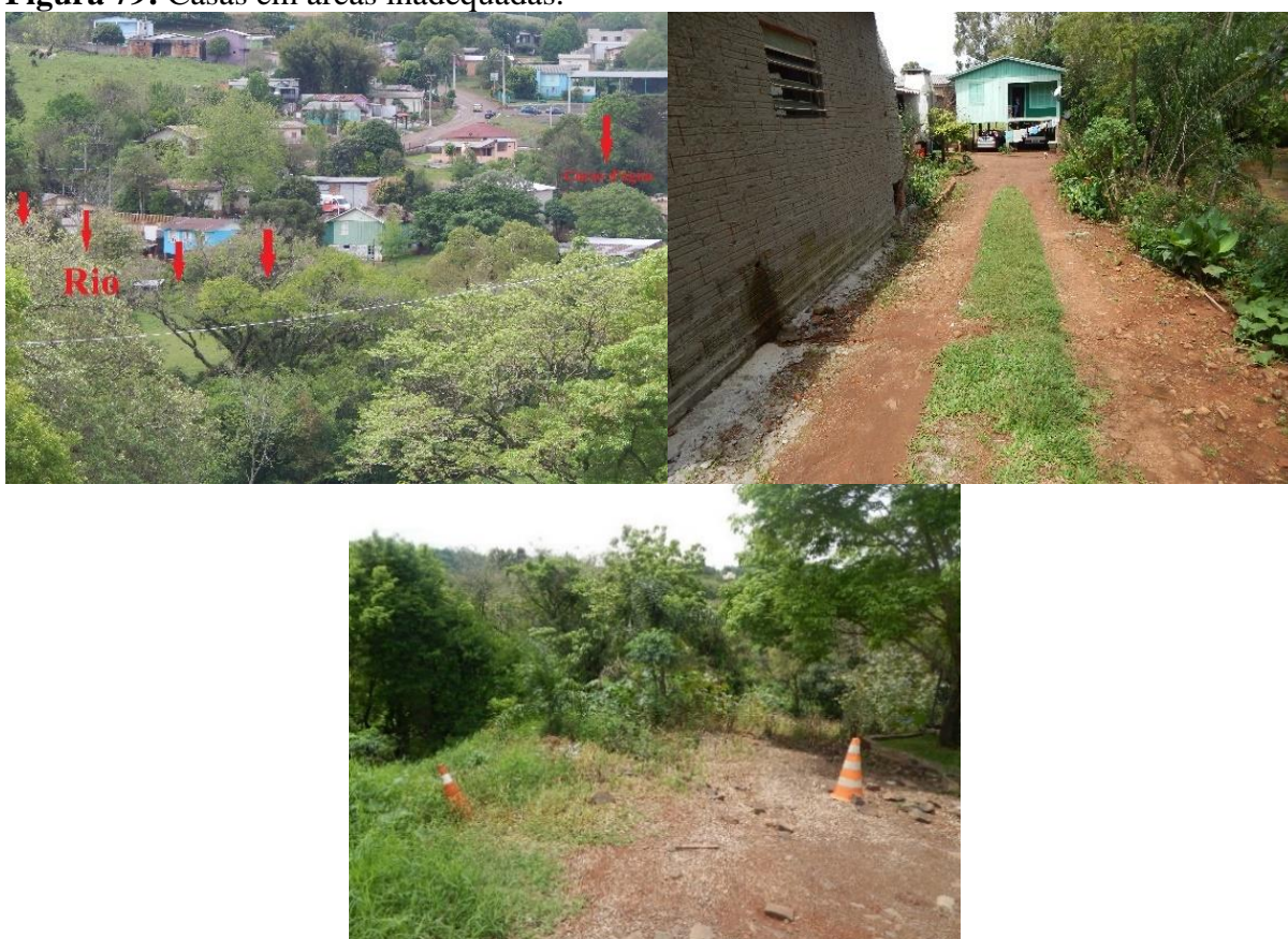
Figura 79: Casas em áreas inadequadas.
