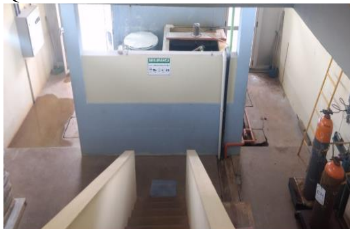
Figura 19: Casa de Química e Laboratório de análises e controle.
