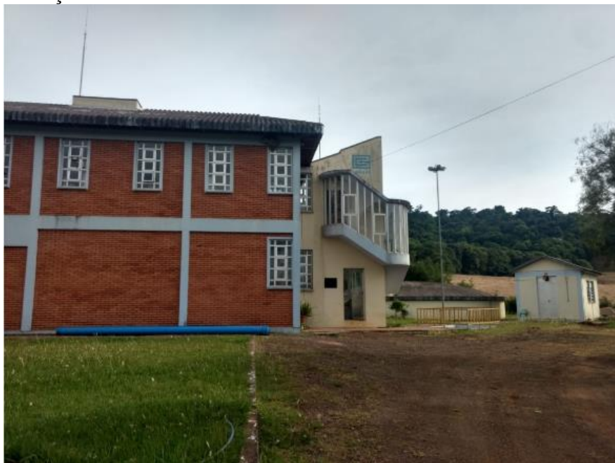
Figura 18: Instalações da ETA de Sarandi-RS.
