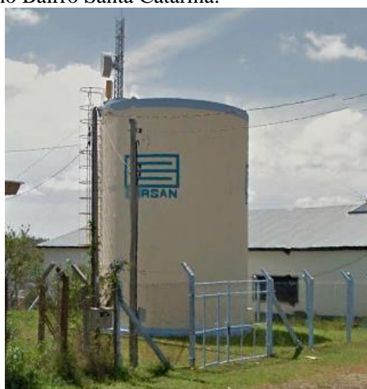
Figura 26: Reservatório no Bairro Santa Catarina.
