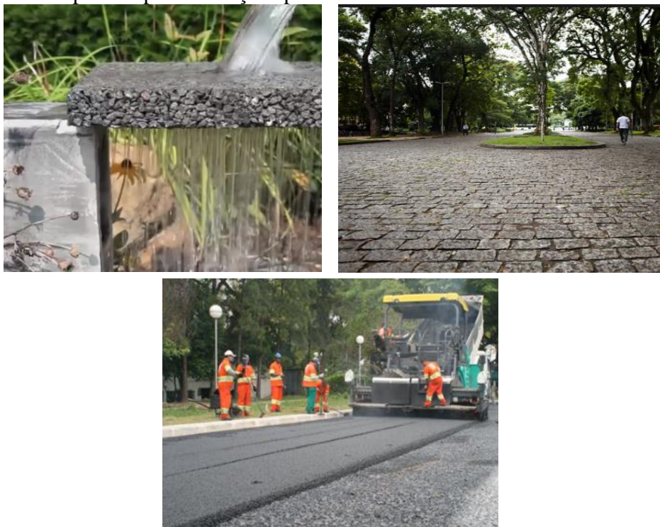
Figura 116: Exemplos de pavimentações permeáveis.
