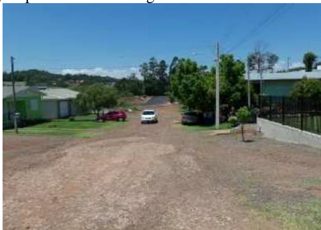
Figura 89: Área atingida pela falta de drenagem em 2014.
