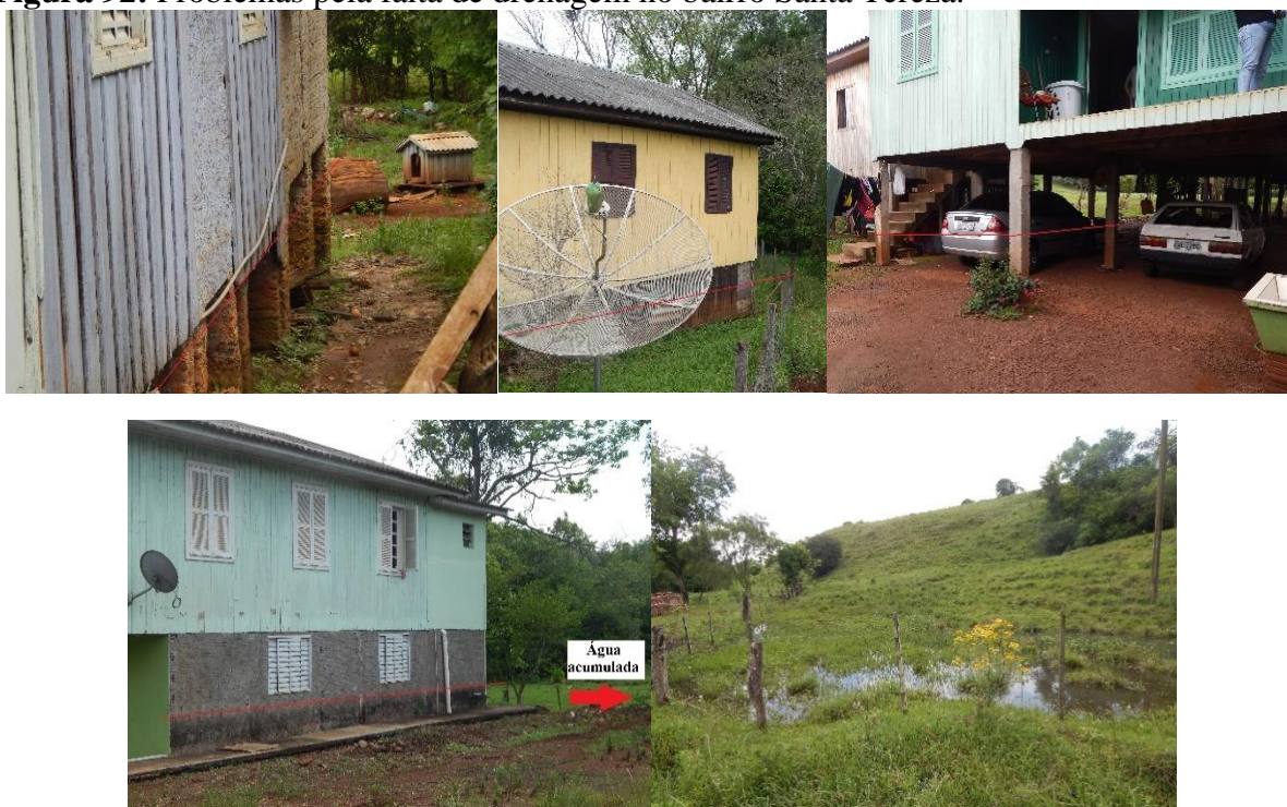
Figura 92: Problemas pela falta de drenagem no bairro Santa Tereza.
