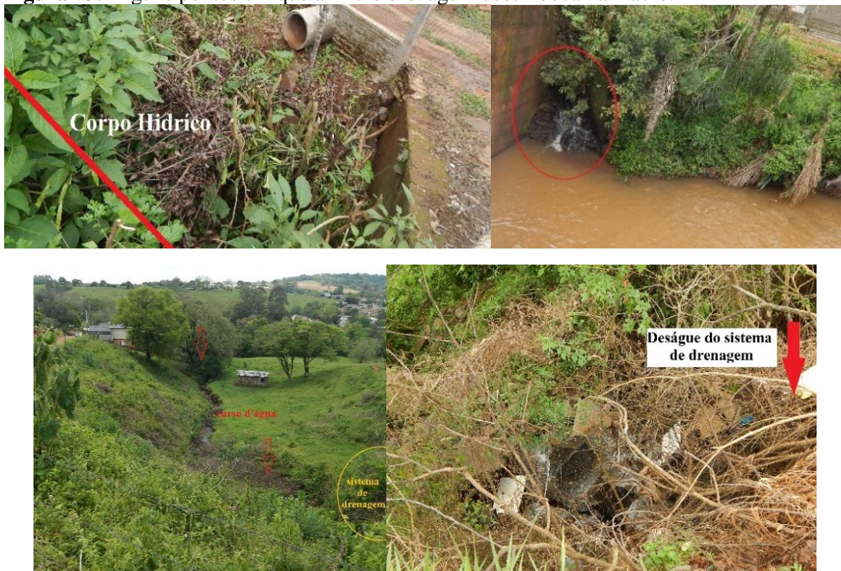
Figura 73: Alguns pontos em que a micro drenagem desemboca na macro.
